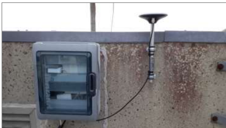
Figure 1: antenne fixe (base) centipède installée sur le toit de l'IUEM.
